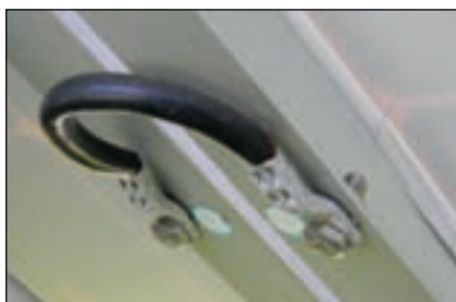
Bild 3: Es ist nicht absolut klar, wann die Erdung von Modul-Rahmen vorgeschrieben oder verzichtbar ist.
