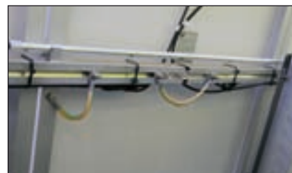
Bild 2: Eine konsequente Erdung des Modul-Rahmens findet man in der Praxis nicht oft.
