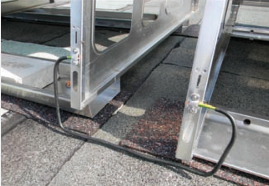
Bild 1: 16 mm 2 Kupfer als konstruktiver örtlicher Potentialausgleich, Schutzpotentialausgleich und Funktionserdung (Blitzschutz) in einem.
